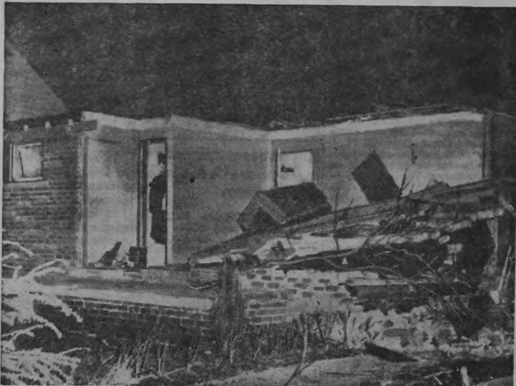
Esta vivienda en Allen Park, un suburbio de Detroit, fue demolida cuando un tornado azotó a la población destruyendo casas y causando numerosos heridos. Por lo menos 12 personas perecieron en una serie de tornados que azotaron a Ohio, Michigan y partes de Ontario. Centenares de edificios fueron derribados.
